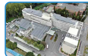
◆ 2024 院區設置太陽能板發電
