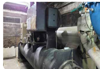
◆ 汰換前 TRANE400RT 定頻主機 ◆ 汰換前 TRANE400RT 定頻主機
